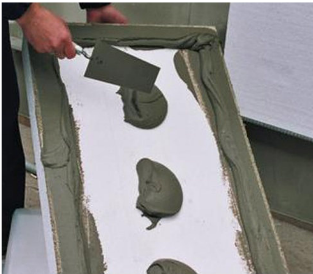
Рис. 13. Нанесение клеевой смеси на плиту утеплителя.
