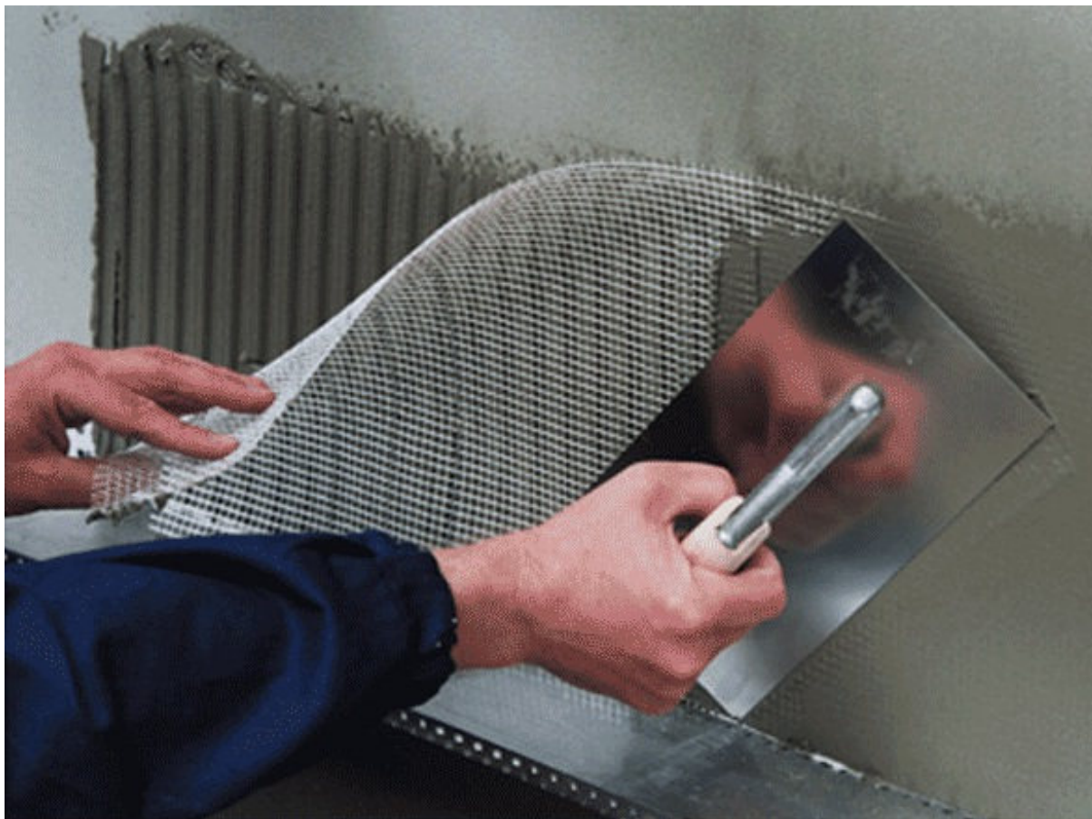
Рис. 20. Крепление армирующей сетки к утеплителю.
