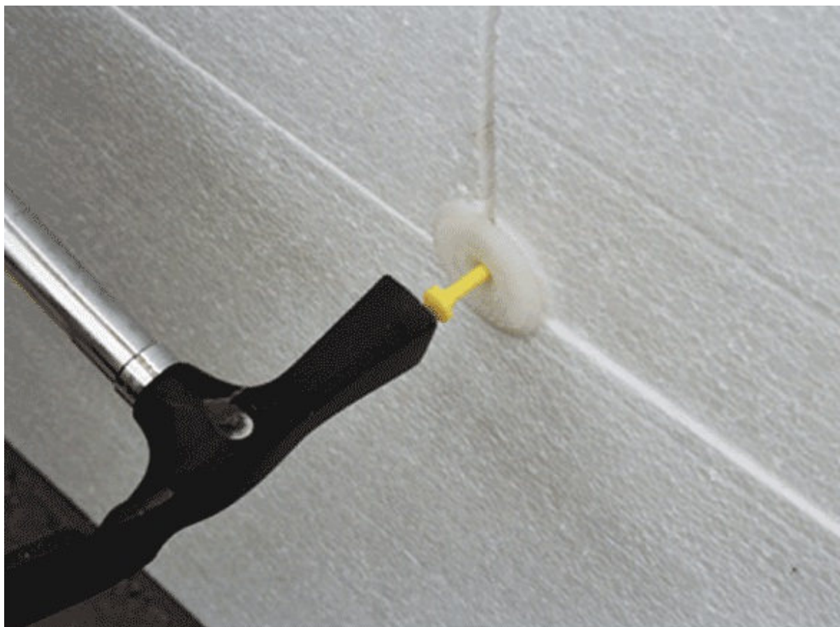
Рис. 19. Забивание распорных наконечников в дюбели
