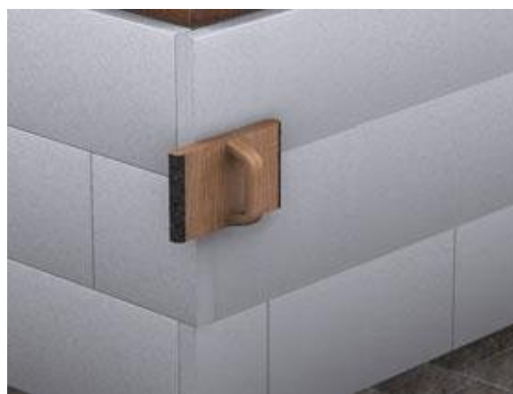
Рис. 15. Наклейка утеплителя в углах
