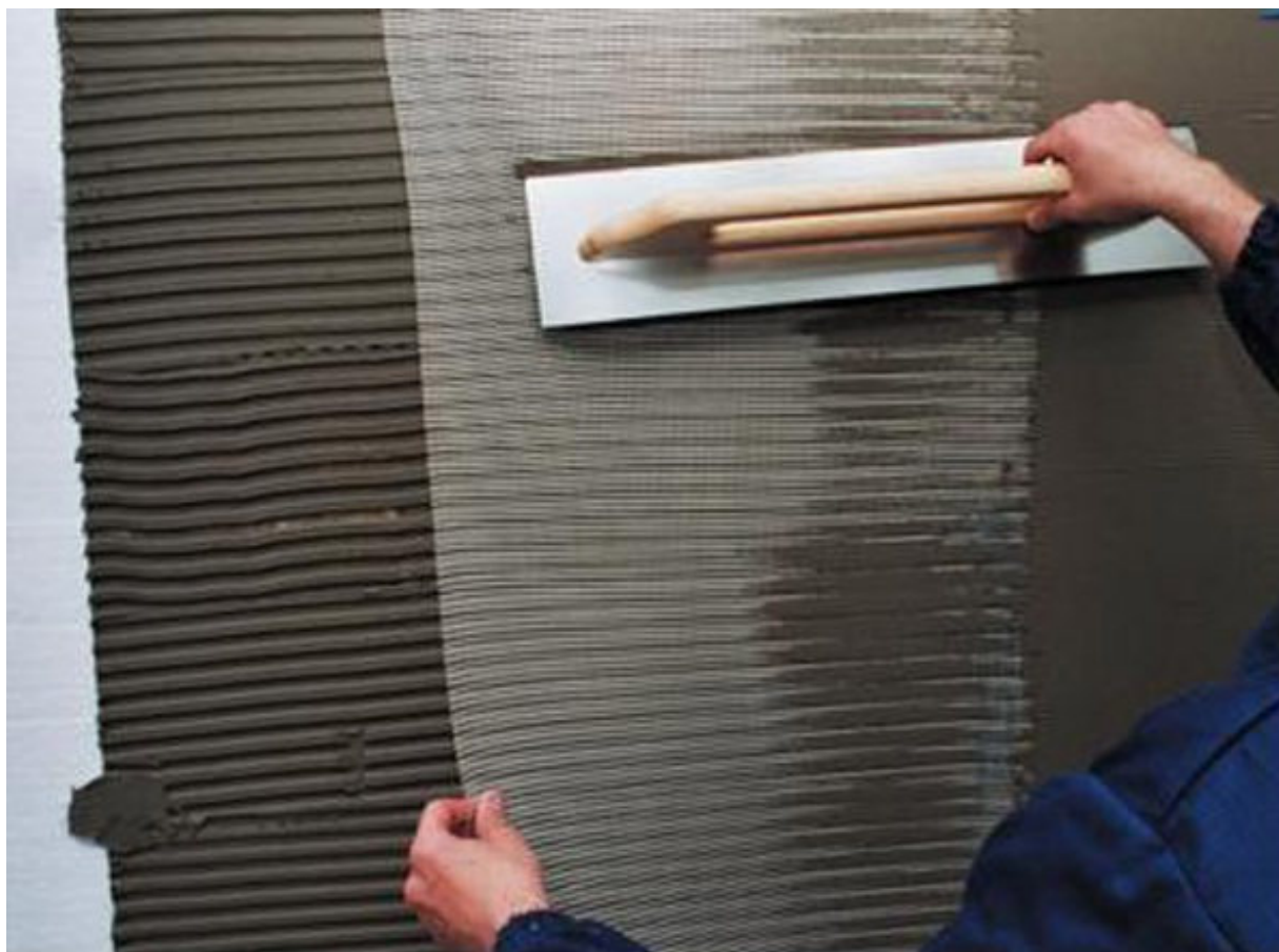
Рис. 21. Крепление армирующей сетки к утеплителю.
